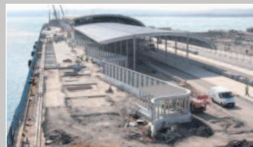
Travaux déjà bien avancés et dans les délais.
