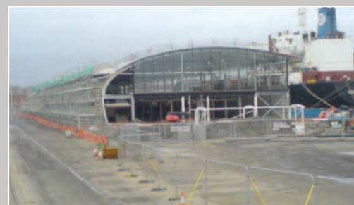
Finition de la façade externe en phase finale des travaux.
